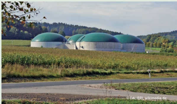
Blick auf eine Biogasanlage. Die charakteristisch geformten Fermenter und Gärrestlager sind auch aus der Ferne deutlich zu erkennen.
