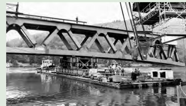
Bau der ICE-Brücke über den Main bei Nantenbach im Jahr 1992. Zu dieser Zeit wurde die neue ICE-Strecke im Sinntal bereits nach Fahrplan befahren.
