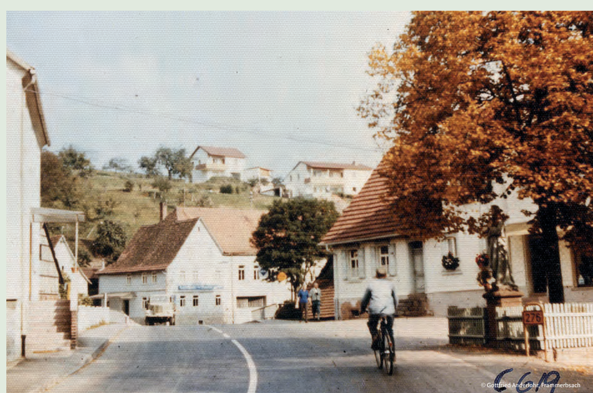
In Frammersbach entstehen neue Wohnhäuser am Hang oberhalb des alten Ortskerns.
