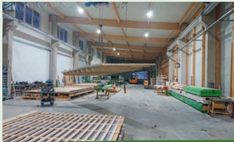
Vormontage der Schutzhütten in der Zimmerei Herchet (Flörsbachtal)
